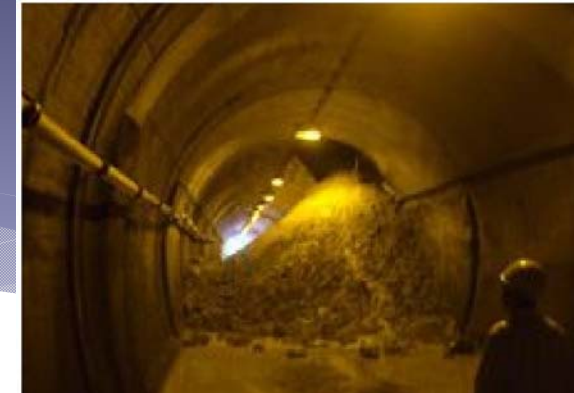
愛知県トンネル崩落事故状況 NHKスペシャル 「調査報告日本のインフラが危ない」より
