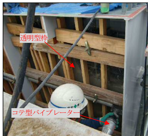
図-5 巻き立てコンクリート打設状況
