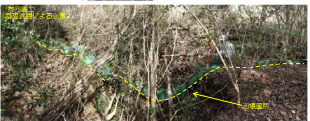
図4 現場全景及び各種変状状況
