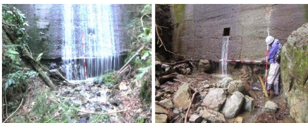
図-7 コンクリート砂防堰堤における洗掘(基礎)の変状事例
