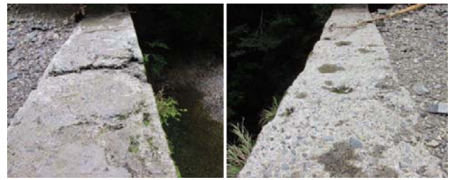
図-1 コンクリート砂防堰堤における天端摩耗の変状事例
