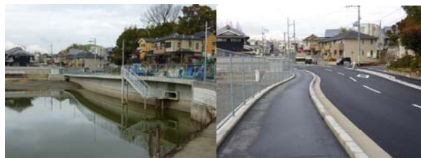
図-9 施工完了後の様子
