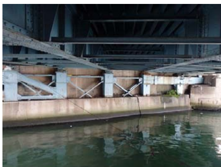
写真-1. 橋台部構造
