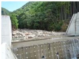
捕捉状況(堰堤部)
