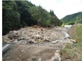
捕捉状況(上流)
