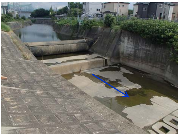
写真-3 取水堰上流の湛水状況
