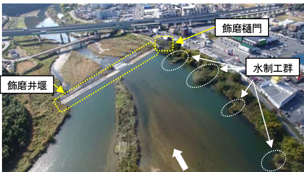
図-3 水制工群周辺の空中写真
