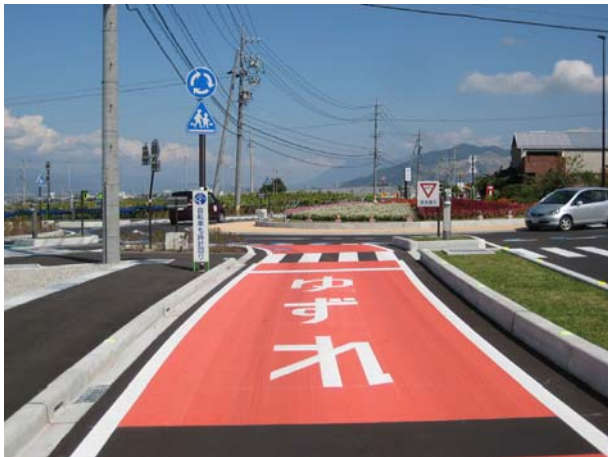
写真-1 カラー舗装の適用事例 (長野県須坂市) 6)
