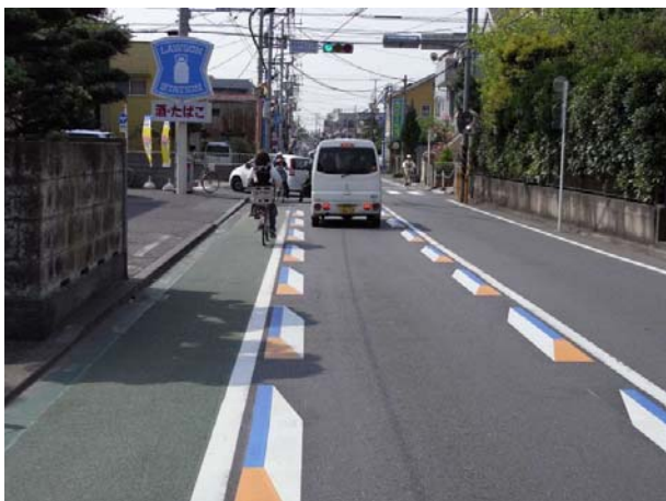
写真-2 交差点付近へのイメージハンプの設置事例 7)
