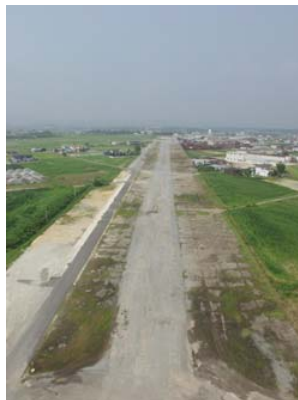
写真-1 現存する滑走路 1)
