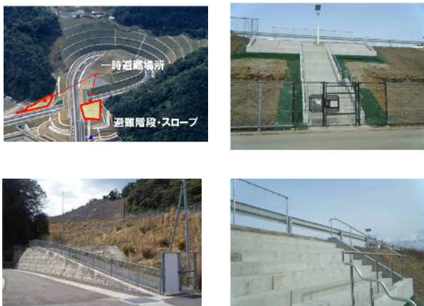
写真-1 避難路設置事例
