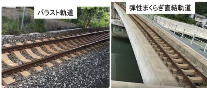
写真-1 バラスト軌道、弾直軌道
