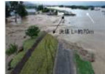
⑪ 千曲川における浸水被害 (長野県長野市穂保地先)
