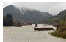
⑫ 球磨川における橋梁流出被害 (熊本県球磨村)
