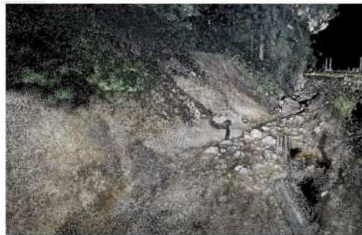
立ち入りが難しい土砂崩壊現場の点群計測も可能に
