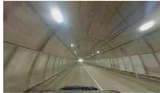
写真-7 トンネル
