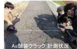
As舗装クラック 計測状況
