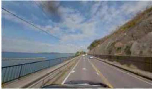
写真-3 走行写真 (前)
