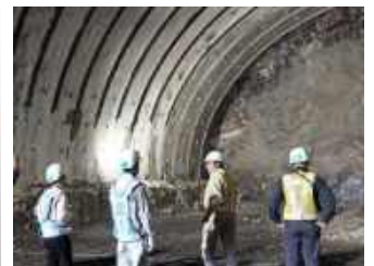
AI活用トンネル施工現場の 視察および意見交換
