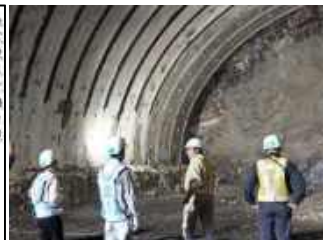
AI活用トンネル施工現場の視察および意見交換
