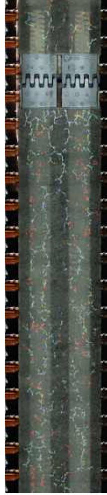
過年度点検結果データの差分によるひび割れ進展性評価 (赤色:進展の可能性の高い領域)
