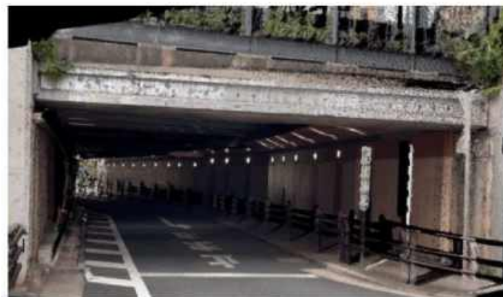
date ▶ 建築物を点群計測した例
