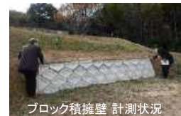
ブロック積擁壁 計測状況
