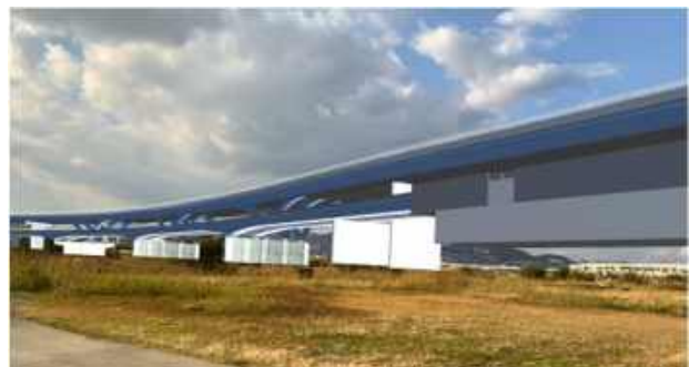
MR (Mixed Reality、複合現実) 現地にて、現実の3次元空間に3次元情報(3Dモデル)を重ね合わせ。
