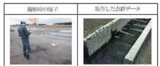
UAVでの写真測量の様子
