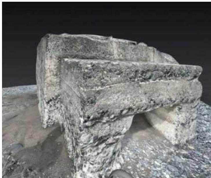
古いコンクリート構造物の 3D 計測データ
