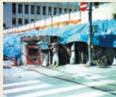
道路沿いの石積擁壁を撤去後に現物利用
