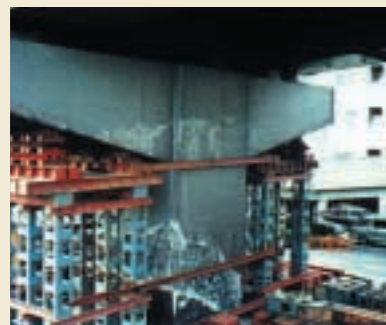
補強による仮復旧
