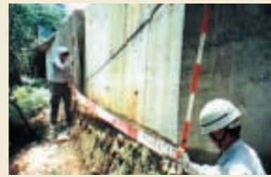
損傷点検調査のようす
