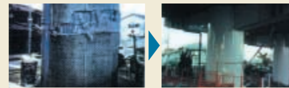
RC巻き立て+鋼板巻き立てを復旧工法としている
