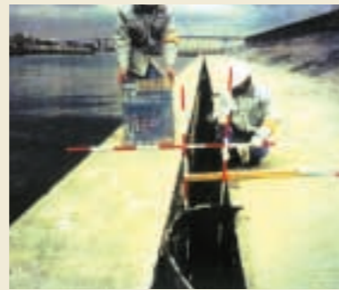
地盤沈下調査
