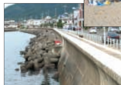
よく見られるコンクリートの直立護岸
