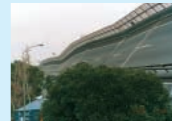
阪神高速道路倒壊
