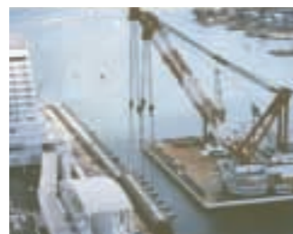
早期復旧に貢献したジャケット工法
