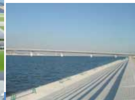
階段式親水護岸（工事中）
