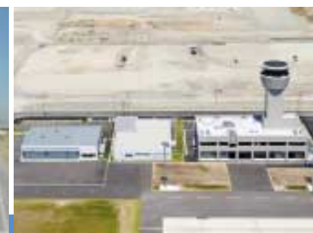
電源局舎・消防庁舎・管制塔
