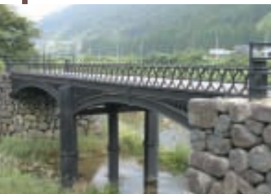
1【鑄鉄橋】純鉄に2-4%の炭素やマンガン、リン、硫黄などを含有した鉄でできた橋 2【スパンドレル】アーチの外輪と垂直部材によってできる三角形の部分
