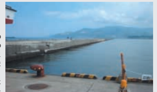
100年の荒波に耐えてきた斜塊ブロック (防波堤の下部)
