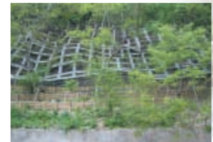
環境に配慮して作られた法枠工
