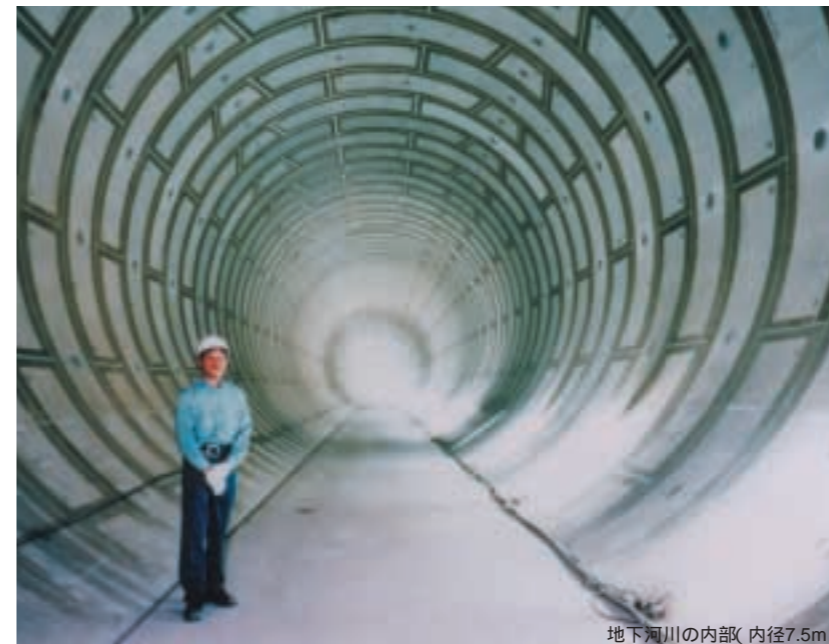
地下河川の内部(内径7.5m)
