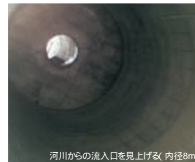
河川からの流入口を見上げる(内径8m)
