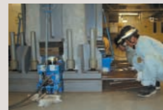
ジャッキアップの様子
