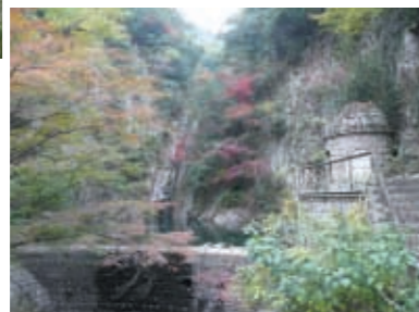
雌滝(布引の滝)、右側には取水塔(明治33年)
