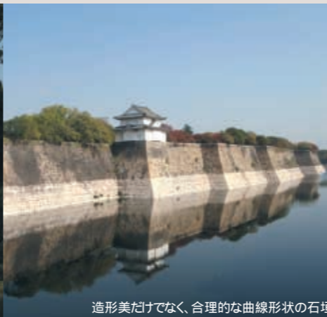
造形美だけでなく、合理的な曲線形状の石垣
