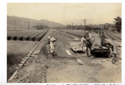
各地で自動車道路の建設が進む
