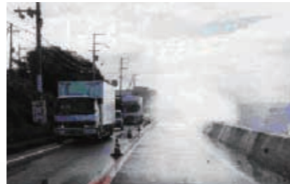
越波で片側通行の国道42号(田辺市)
