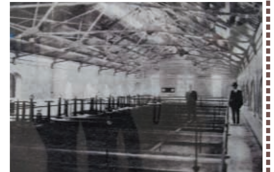
建設当時の浄水場
