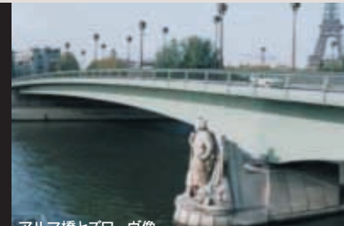
アルマ橋とズワーヴ像 (社)土木学会関西支部「土木のギャラリー ヨーロッパの橋」より
