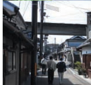
新町通りの高架橋
