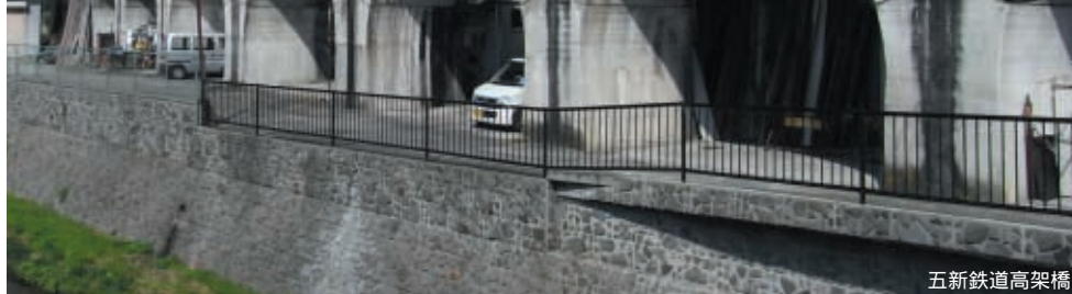
五新鉄道高架橋
