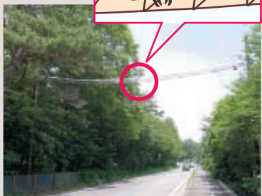
設置例写真は山梨県北杜市HPより
