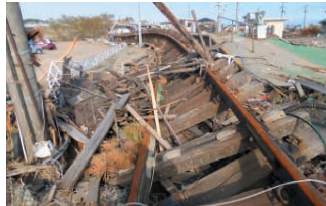
上：防波堤は津波の威力で損壊してしまった( 岩手県釜石市 ) 下：レールがねじ曲げられたJR仙石線東名駅( 宮城県東松島市 )
