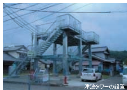
津波タワーの設置
