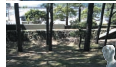
上:濱口梧陵が築造した広村堤防 下:畠山氏に既に築かれていた防波堤 右:濱口梧陵の石像
