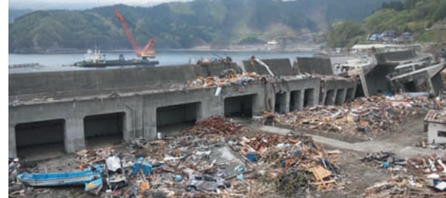
上：防波堤は津波の威力で損壊してしまった( 岩手県釜石市 ) 下：レールがねじ曲げられたJR仙石線東名駅( 宮城県東松島市 )
