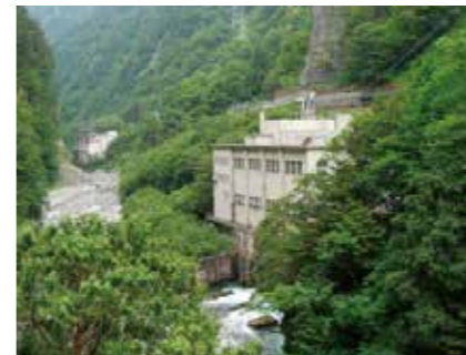
黒部第三発電所(樺平駅近傍)
