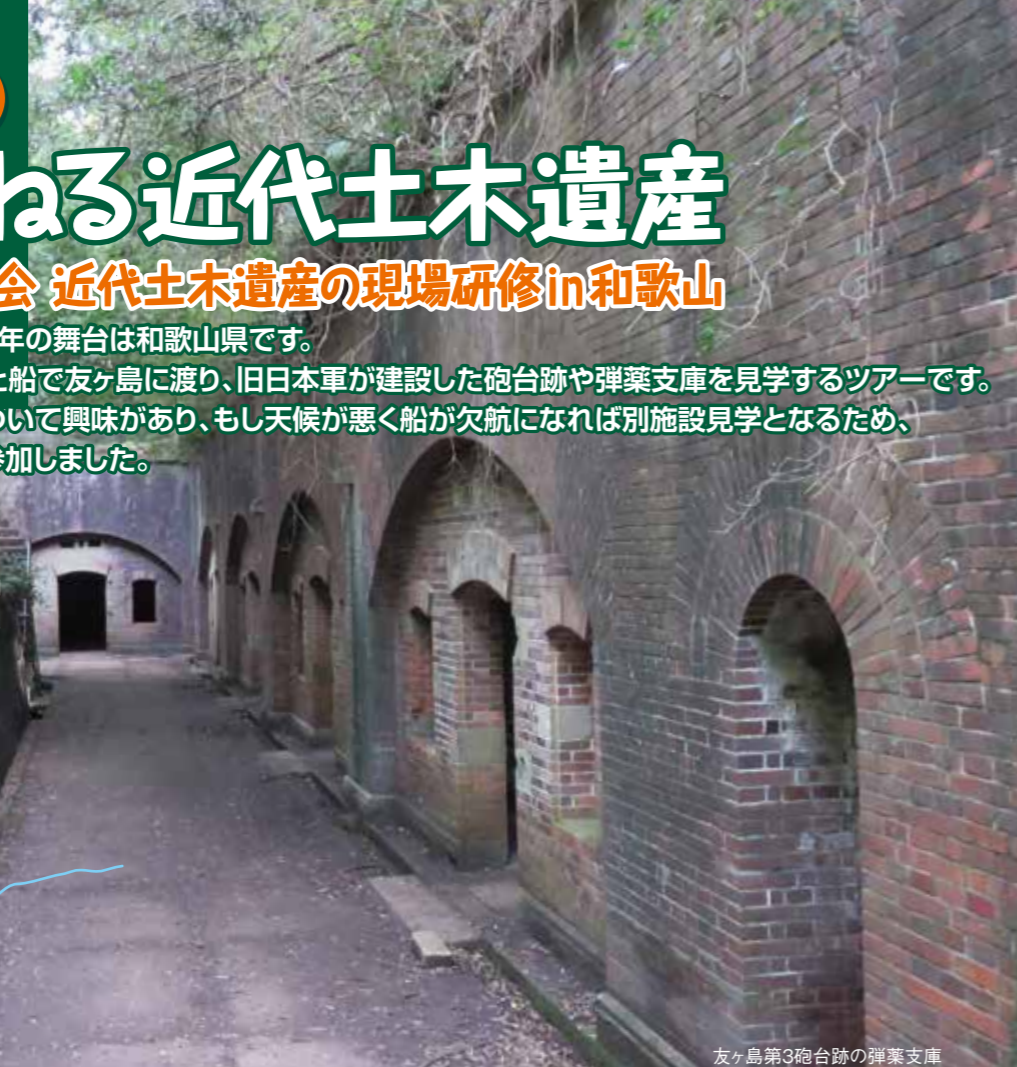
友ヶ島第3砲台跡の弾薬支庫
