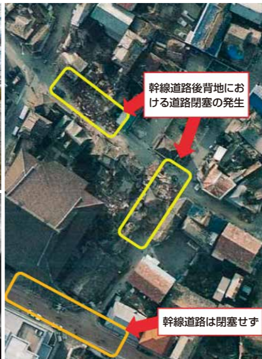
阪神・淡路大震災 道路閉塞状況
