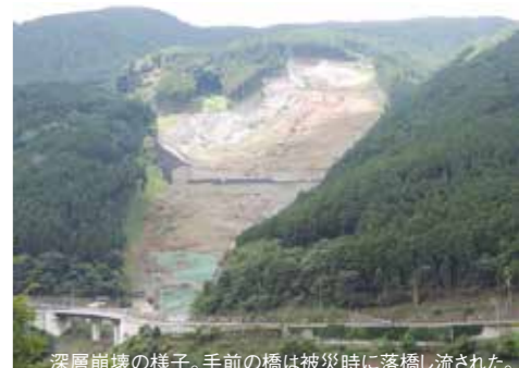
深層崩壊の様子。手前の橋は被災時に落橋し流された。
