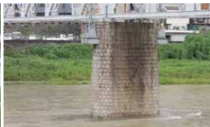
切石積みの橋脚
