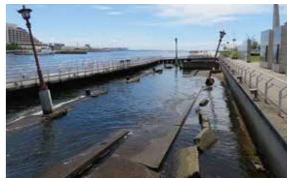
斜めに傾いた街灯と岸壁が海面に沈んだままの「神戸港震災メモリアルパーク」
