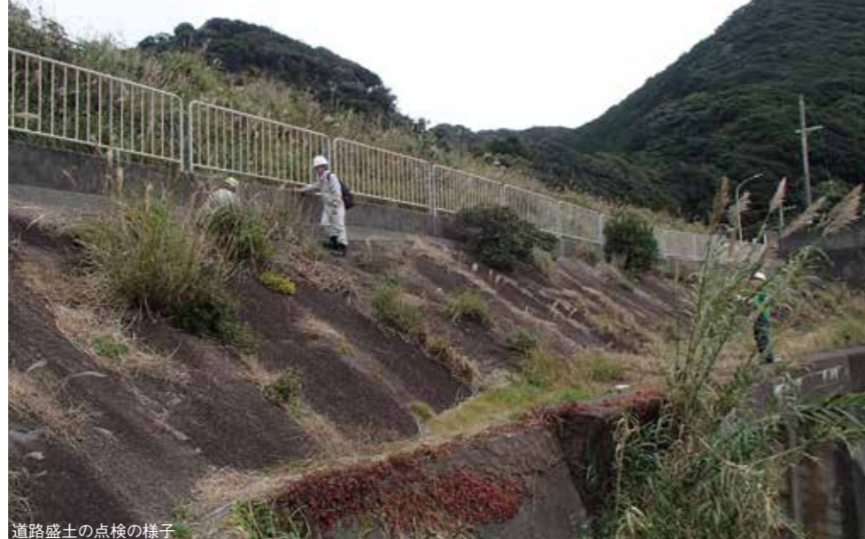
道路盛土の点検の様子
