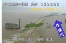
⑨牛津川の浸水被害 (佐賀県小城市)
