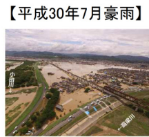
⑥小田川における浸水被害 (岡山県倉敷市)
