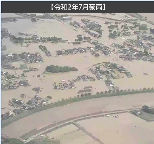
③人吉市街部における浸水被害（熊本県人吉市）
