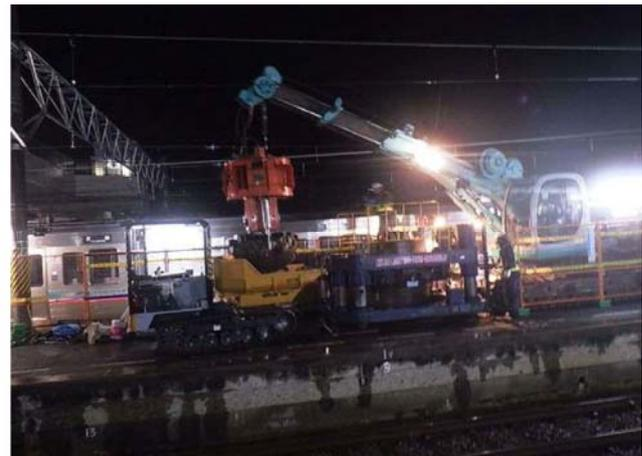
図-5 島式ホームでの掘削状況
