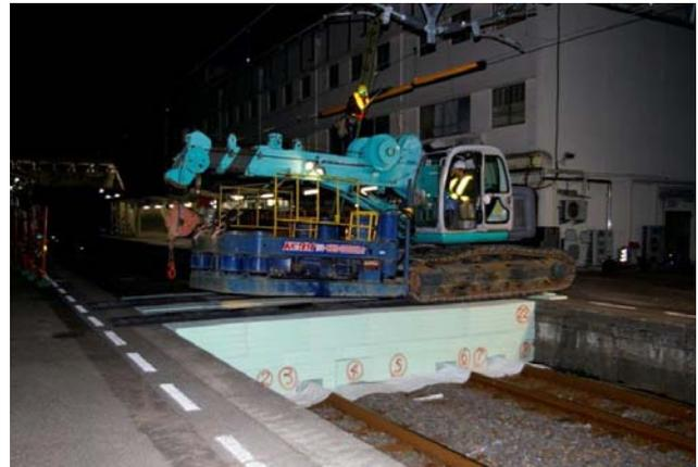
図-4 ホーム間工事前仮設路の設置とケコム工法施工機械の移動状況
