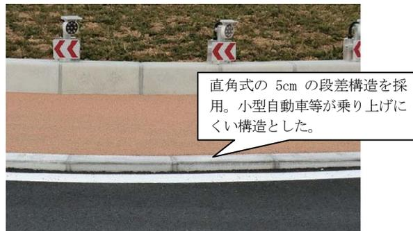
図-9 直角式のエプロン縁石 (5cm の段差構造)
