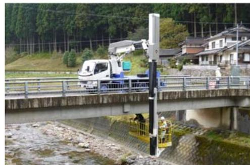
図-1 橋梁点検車による点検
