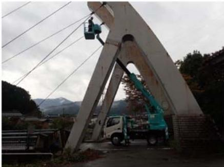
図-2 高所作業車による点検
