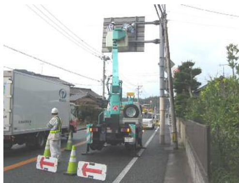
写真-1 高所作業車による近接目視
