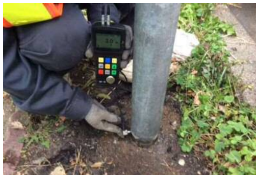
写真-3 路面境界部の板厚調査状況
