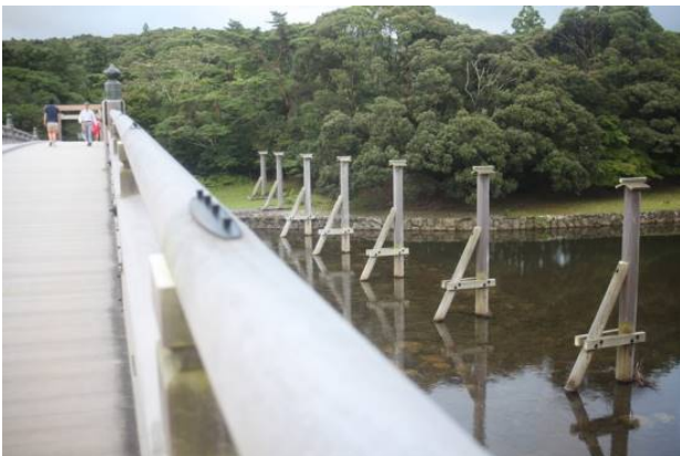
写真—3 伊勢神宮内の宇治橋における木除杭
