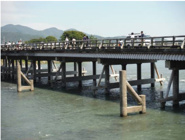
写真—2 嵐山の渡月橋における木除杭
