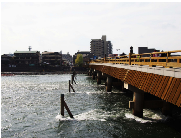
写真—4 宇治川(京都宇治市)の宇治橋における木除杭
