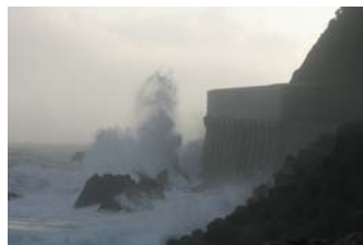
写真-1 越波状況
