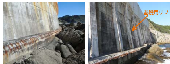
写真-4 先行整備区間擁壁
