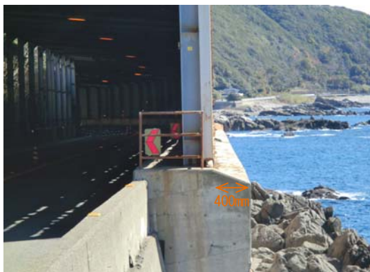
写真-7 現況擁壁天端状況
