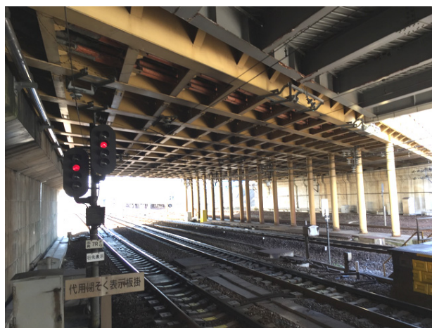
写真-2 橋梁全景(桁下)
