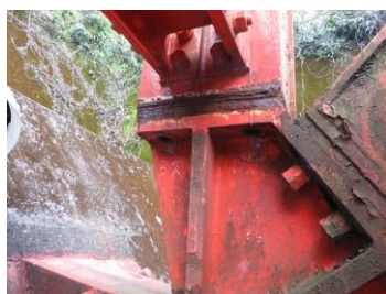
(a) A1 橋台側 (上流側)
