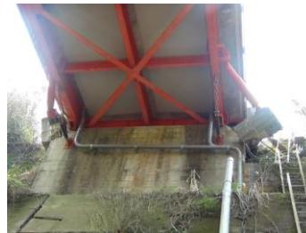
写真-2 A2 橋台側に生じた水平変位と段差
