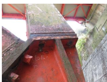
(b) A2 橋台側 (下流側)
