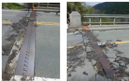
(a) A1 橋台側 (b) A2 橋台側
