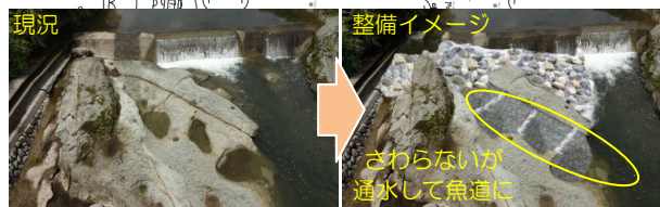
図-8 特徴ある露岩環境の保全・活用、水通しの移設による魚道流量確保
