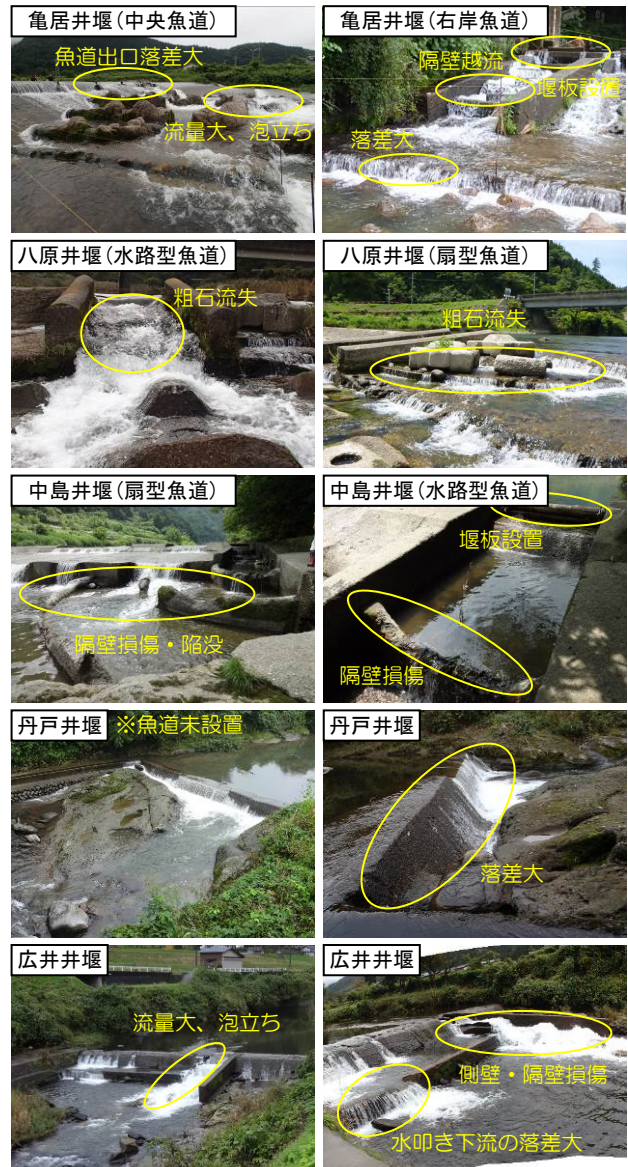
図-2 対象施設現況
