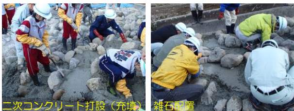
図-5 高校生・利水者・漁業関係者らによる施工
