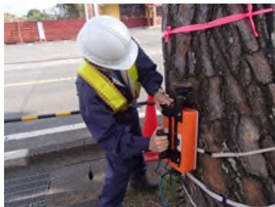
図-5 地中レーダによる精密診断の様子
