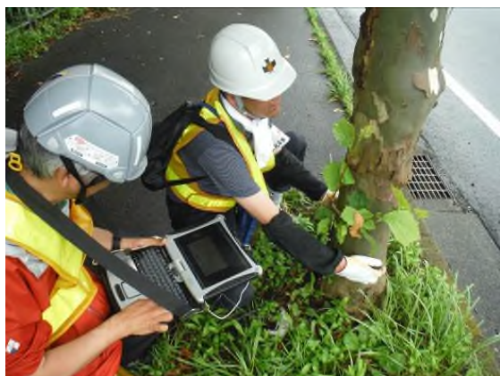
図-3 共振測定装置による簡易診断の様子
