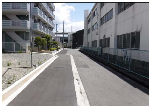
図-11 施工後写真①
