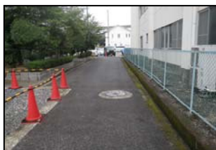
図-2 現況写真①
