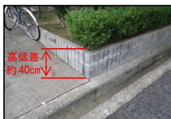
図-9 現況植樹ブロック
