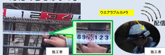
施工者が出来形を撮影し監督職員へ配信
