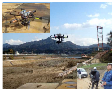
○ UAV(ドローン)による起工測量
