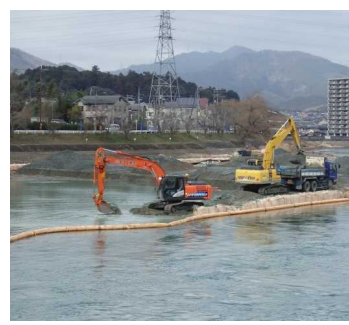
○ ICTバックホウによる水中掘削
