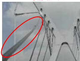
ケーブル損傷・緩み状況
