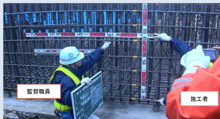
監督職員が現場に臨場して出来形を計測
