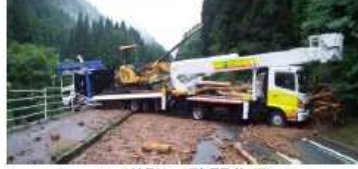
▲ 道路の啓開作業
