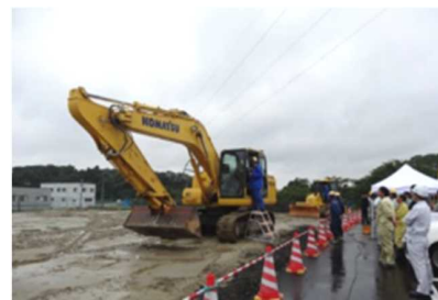
i-Construction「ICT見学会」(宮城県建設業協会)
