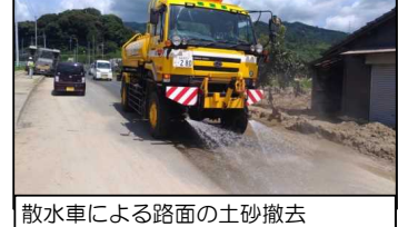
散水車による路面の土砂撤去
