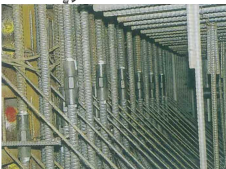
地下構造物施工例
