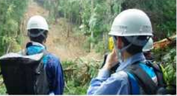
▲ 砂防の被災調査
