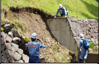
朝倉市での被災状況調査(河川)
