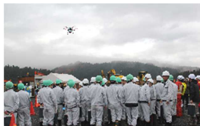
ICT活用土工実証検討会(ICT土工現場勉強会) (秋田県建設業協会、東北測量設計協会、東北地方整備局)
