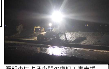
照明車による夜間の復旧工事支援
