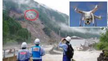
▲ TEC-FORCEによるドローン調査
