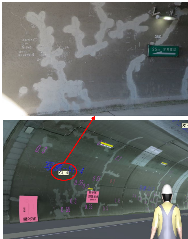
図-11 変状写真とのリンク付け
