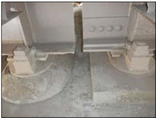
写真-8 支承(補修後)
