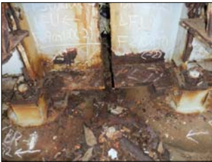
写真-7 支承(補修前)
