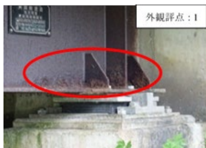
図-4 A 橋のさび生成状況
