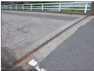
写真-9 伸縮装置(補修前)
