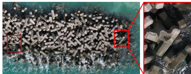
図-13 ブロックの破損
