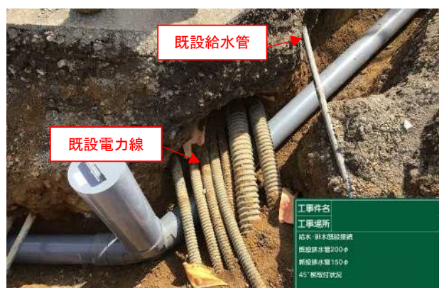
図 4 掘削による埋設管確認状況
