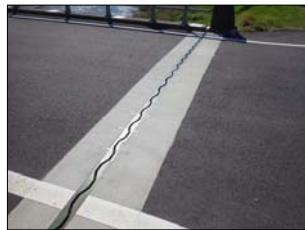
写真-10 伸縮装置(補修後)
