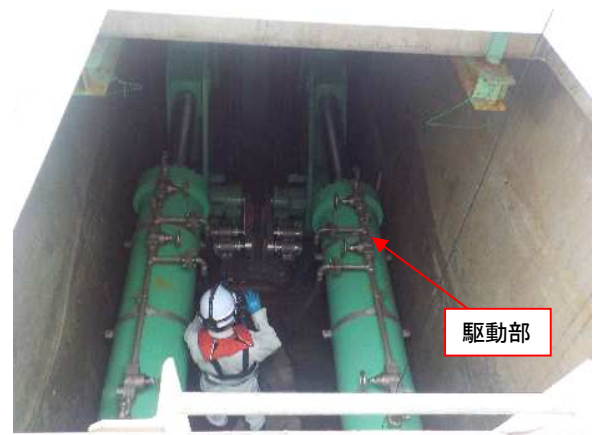
図-5 中空断面堰柱内部の現地写真
