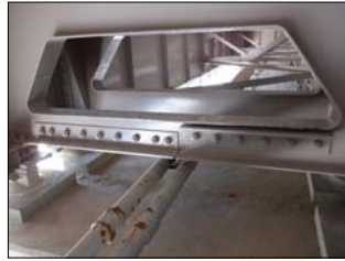
写真-6 横桁(補修後)
