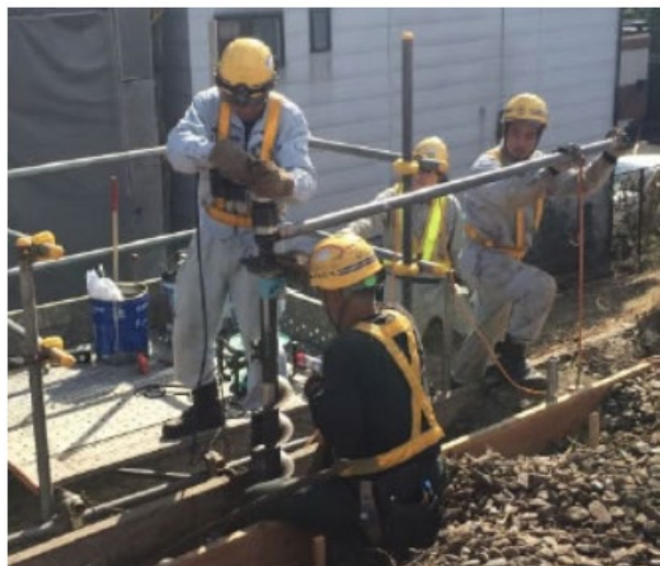
写真-1 杭打設状況図
