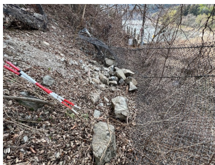
写真-2 損傷した落石防護柵
