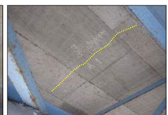
写真-15 床版ひび割れ(新規) 写真-16 床版ひび割れ(設計時)
