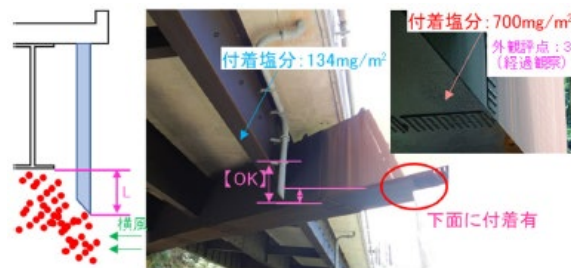
図-6 D 橋の排水管状況
