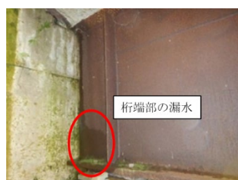
図-7 B 橋漏水箇所
