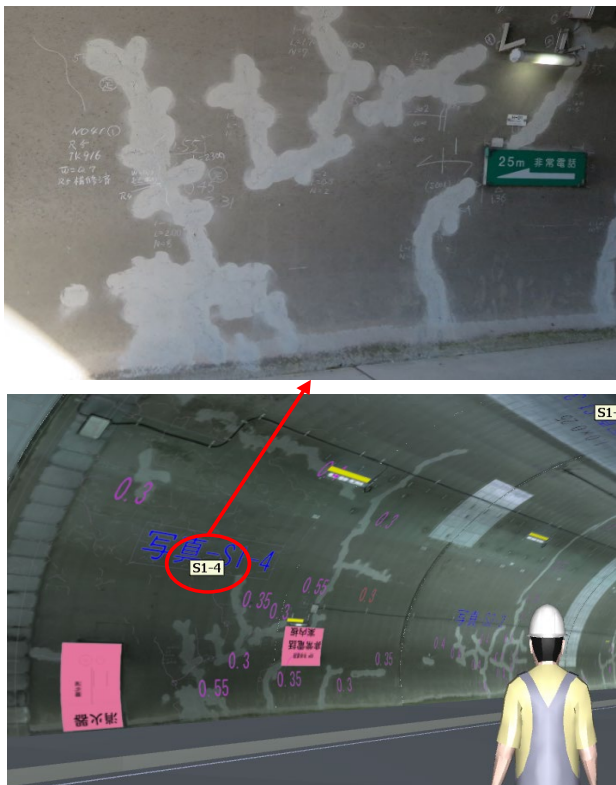
図-11 変状写真とのリンク付け
