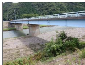
写真-3 主桁(補修前)
