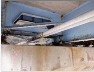
写真-5 横桁(補修前)
