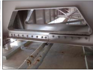
写真-6 横桁(補修後)
