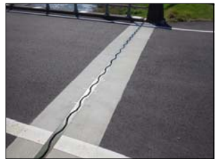
写真-10 伸縮装置(補修後)
