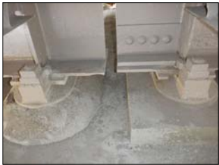
写真-8 支承(補修後)
