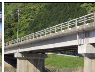
写真-4 主桁(補修後)
