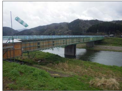
写真-13 足場写真
