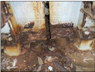
写真-7 支承(補修前)
