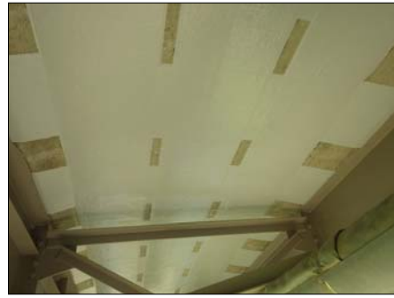
写真-19 炭素繊維シート格子貼り状況(近接)
