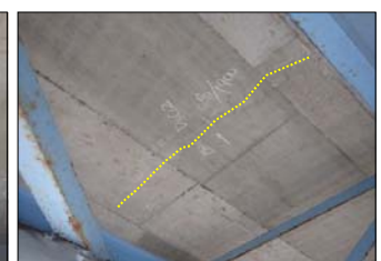
写真-15 床版ひび割れ(新規) 写真-16 床版ひび割れ(設計時)
