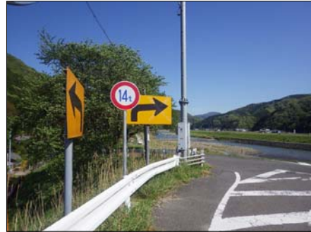
写真-20 14t 規制標識(新規設置)
