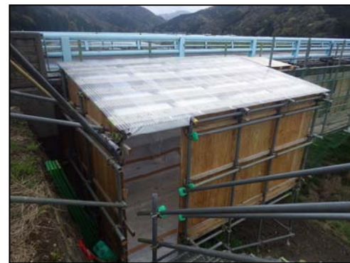
写真-14 セキュリティールーム
