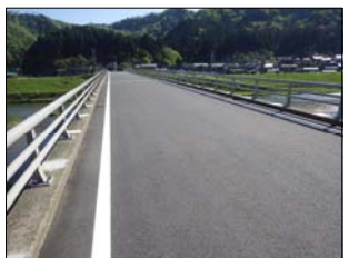
写真-12 橋面(補修後)
