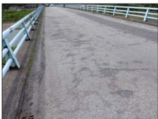
写真-11 橋面(補修前)
