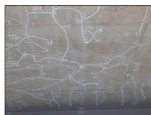
写真-15 床版ひび割れ(新規) 写真-16 床版ひび割れ(設計時)
