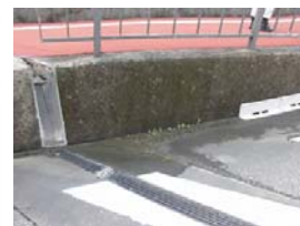
写真-4 A2橋台部地覆高
