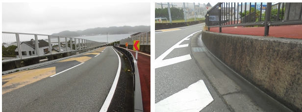
写真-2 橋梁区間
