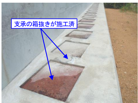
写-3 沓座の状況
