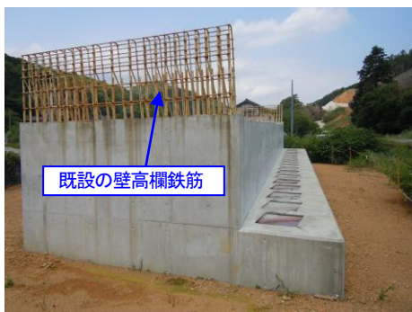
写-1 壁高欄の状況
