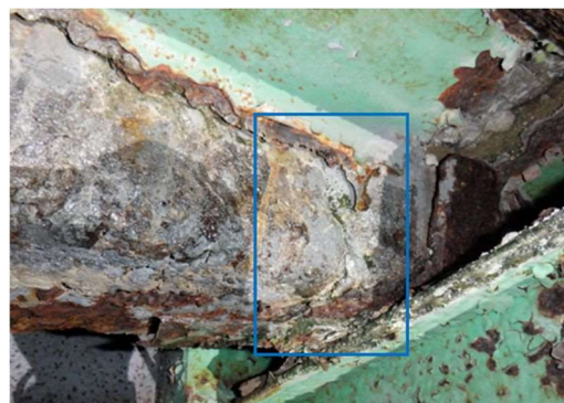
写真-3 対象箇所（露出部拡大：床版端部）
