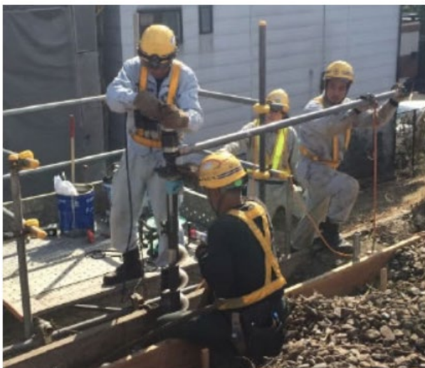
写真-1 杭打設状況図
